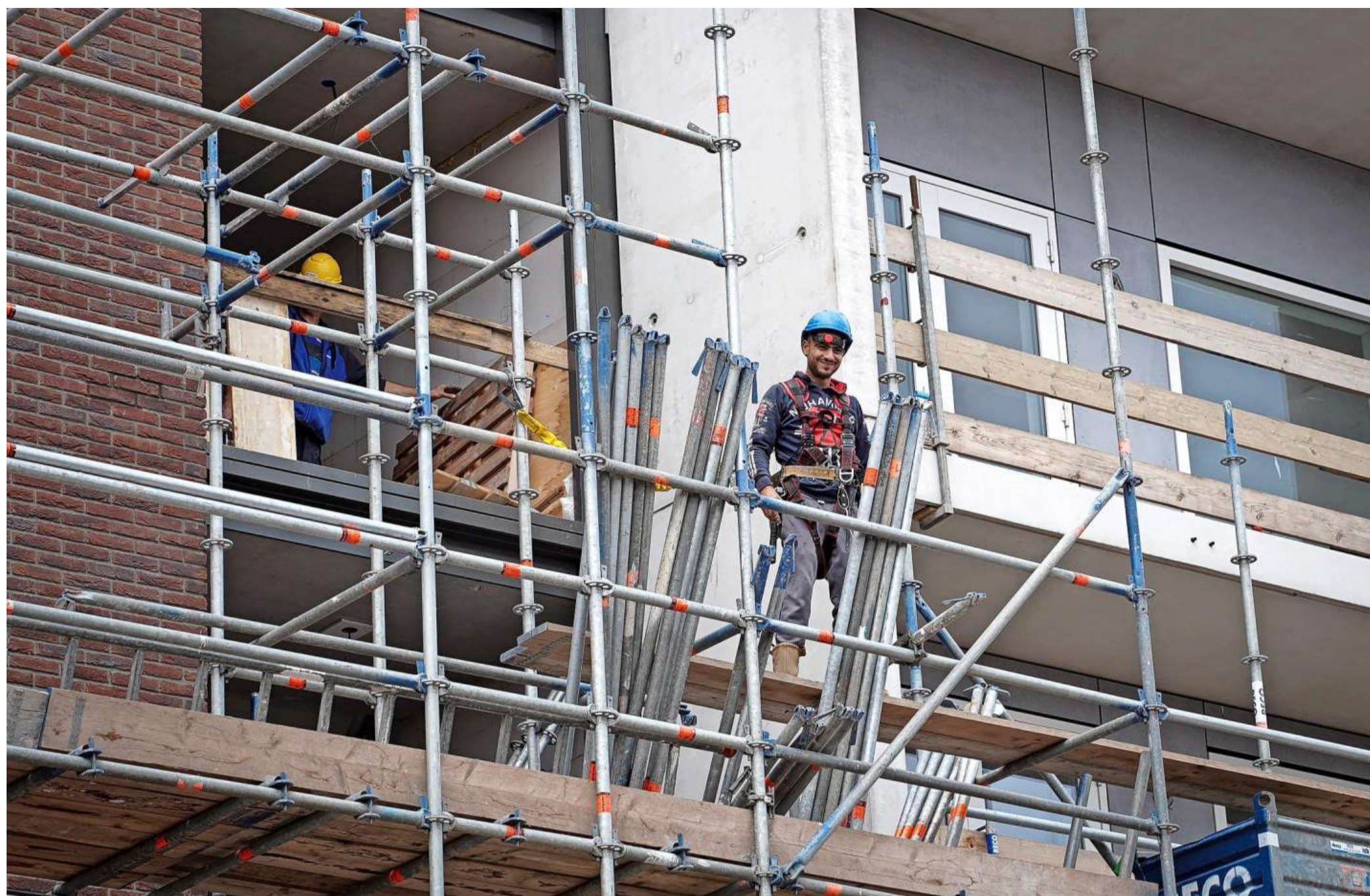
Sociale woningen in aanbouw in Purmerend.
